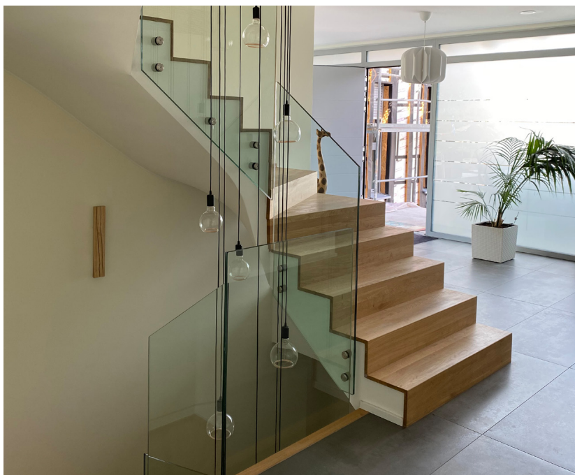
Réalisation d'un garde-corps en verre sur escalier béton avec nos points d'ancrage Lieu chantier maison d'habitation Luxembourg
