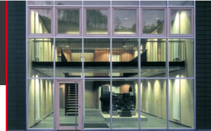
Notre bâtiment à basse énergie primé, administration et marketing
